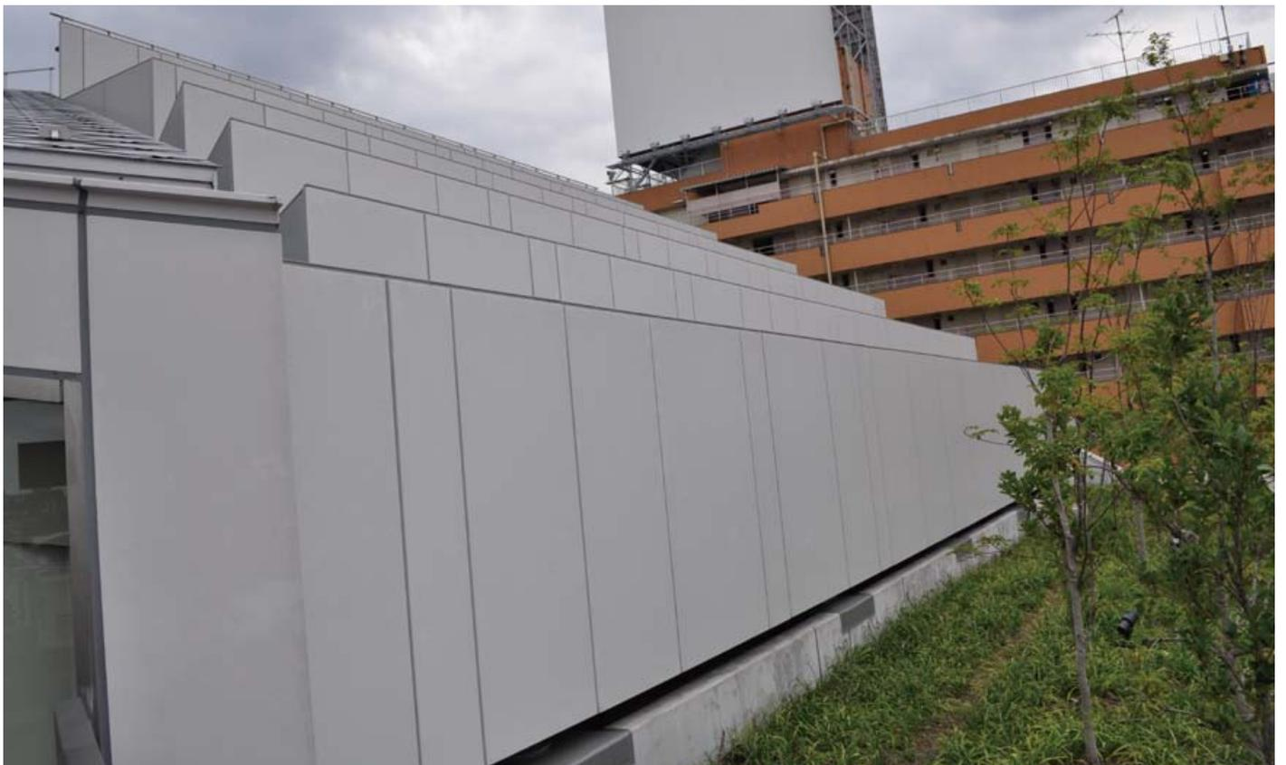
「ルーバーガラルリ吸音タイプ」は、風切音防止型であり、吸音性能を併せ持つ製品です。
