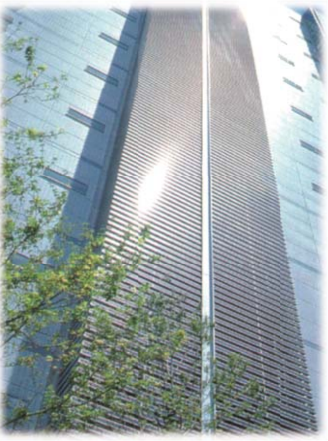
●NTTドコモ武蔵野研究開発センター研究棟(東京都) 設計：(株)NTT ファシリティーズ 部位：ソーラールーバー 施工：大成建設 JV 合計最大出力：36kW
