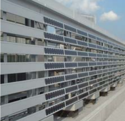
●旧渋谷小学校跡地ビル(東京都) 設計：(株)梓設計 部位：屋上ソーラールーバー 施工：鹿島建設 JV 合計最大出力：5.5kW
