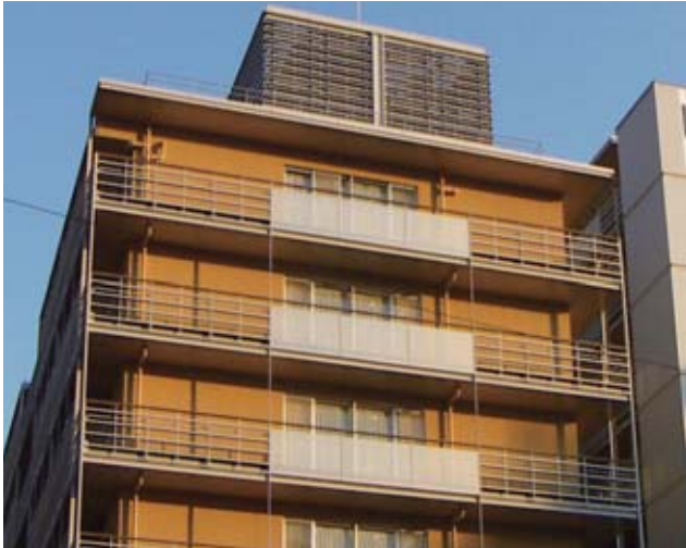
●旧渋谷小学校跡地ビル(東京都) 設計：(株)梓設計 部位：屋上ソーラールーバー 施工：鹿島建設 JV 合計最大出力：5.5kW
