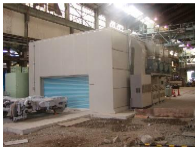
新幹線用屋内防音テストルーム
